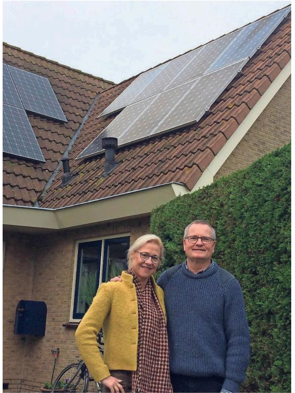
31 zonnepanelen op het dak.
